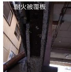
これらの建材は飛散しやすいアスベストを含有している可能性があり、石綿障害予防規則により石綿粉じんの飛散を防ぎながら除去しなければなりません。
